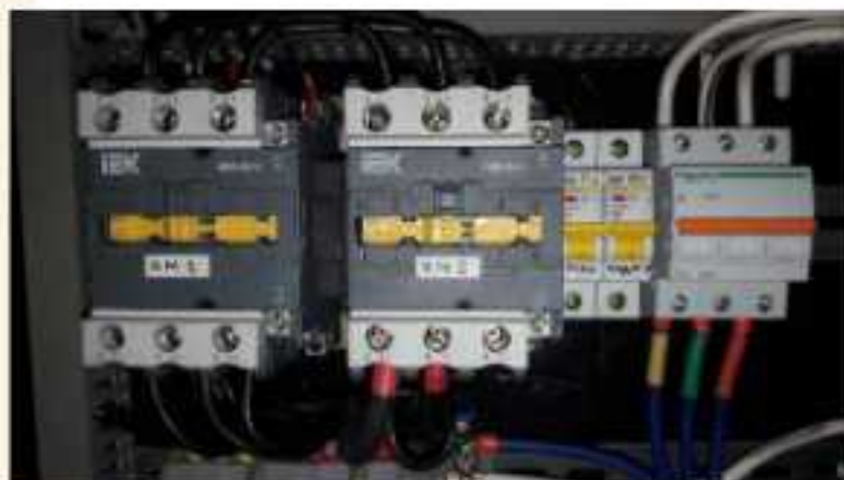
Контактор КМИ 18А, 50Гц 400В для аппаратов серии FX, FS Германия
